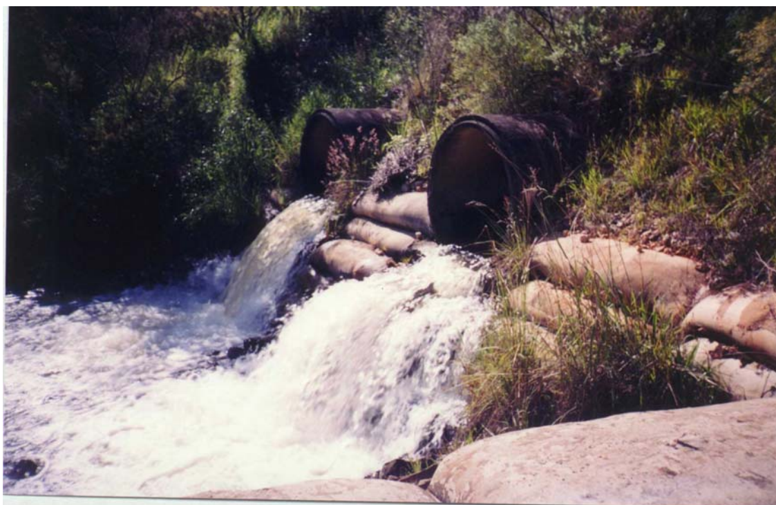
FIGURA 3.12 - VISTA DE JUSANTE DO VERTEDOR TIPO "MONGE"
