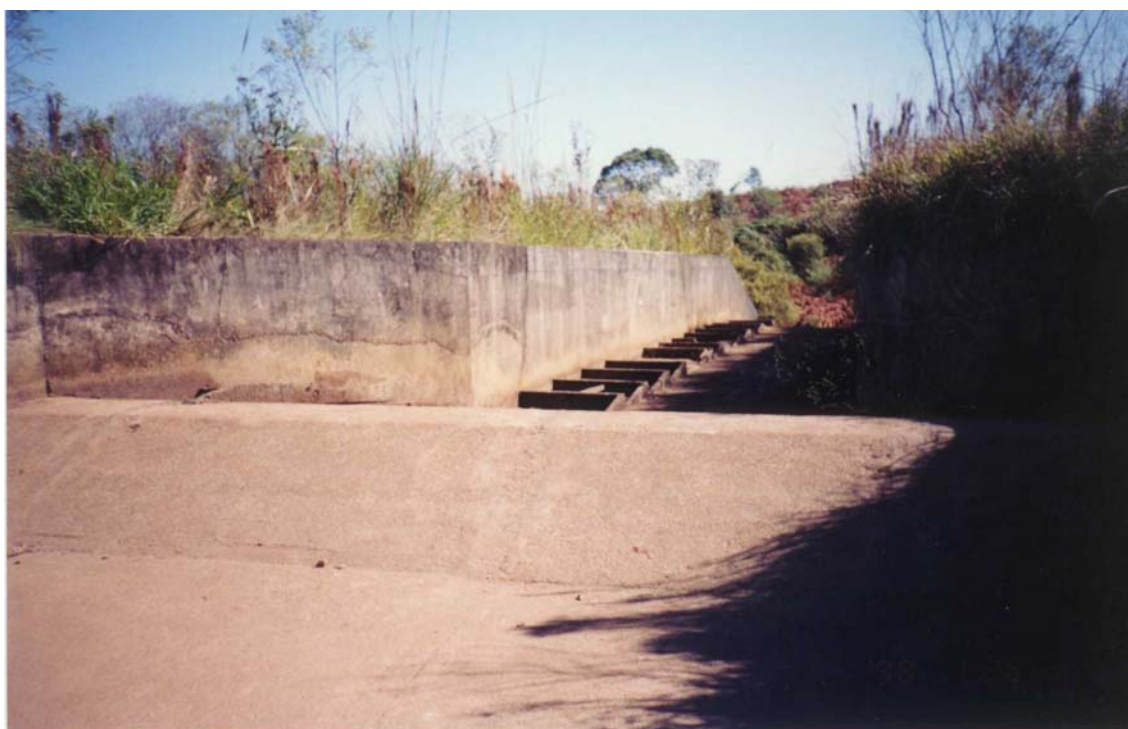
FIGURA 3.11 - VISTA DE MONTANTE DE UM DOS VERTEDORES DE LÂMINA LIVRE
